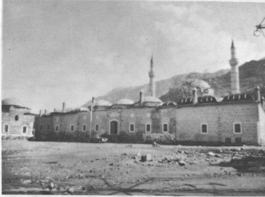
RESİM: 28/a Manisa Vakıf Orta öğrenim öğrenci Yurt binasının güney cephesindeki büyük giriş kapısı
