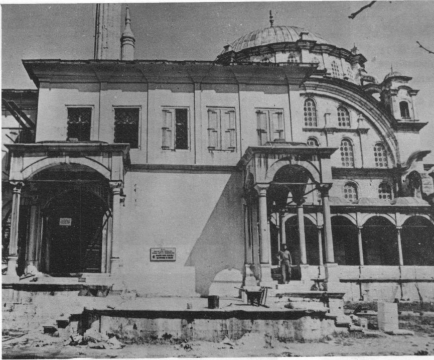
RESİM: 13/a İstanbul-Üsküdar Selimiye Camii Hünkâr mahfelinde Vakıf İbrahim Hakkı Konyalı Kütüphanesinden bir görünüş.
