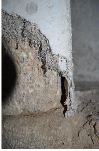
Şekil 7. Niğde İli Bor İlçesi'nde Bulunan Ermeni Kilisesi (Cıgızoğlu Konağı) Duvar Resimlerinde Sıva Tabakasında Ayrışma ve Ayrılmalar
