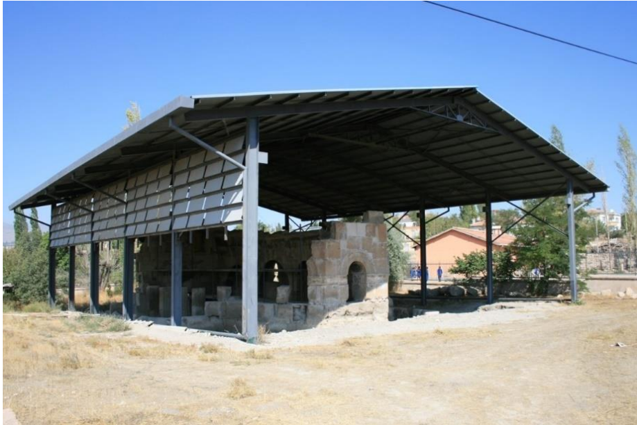
Şekil 27. Kilise Üzerine İnşa Edilen Koruma Çatısı
