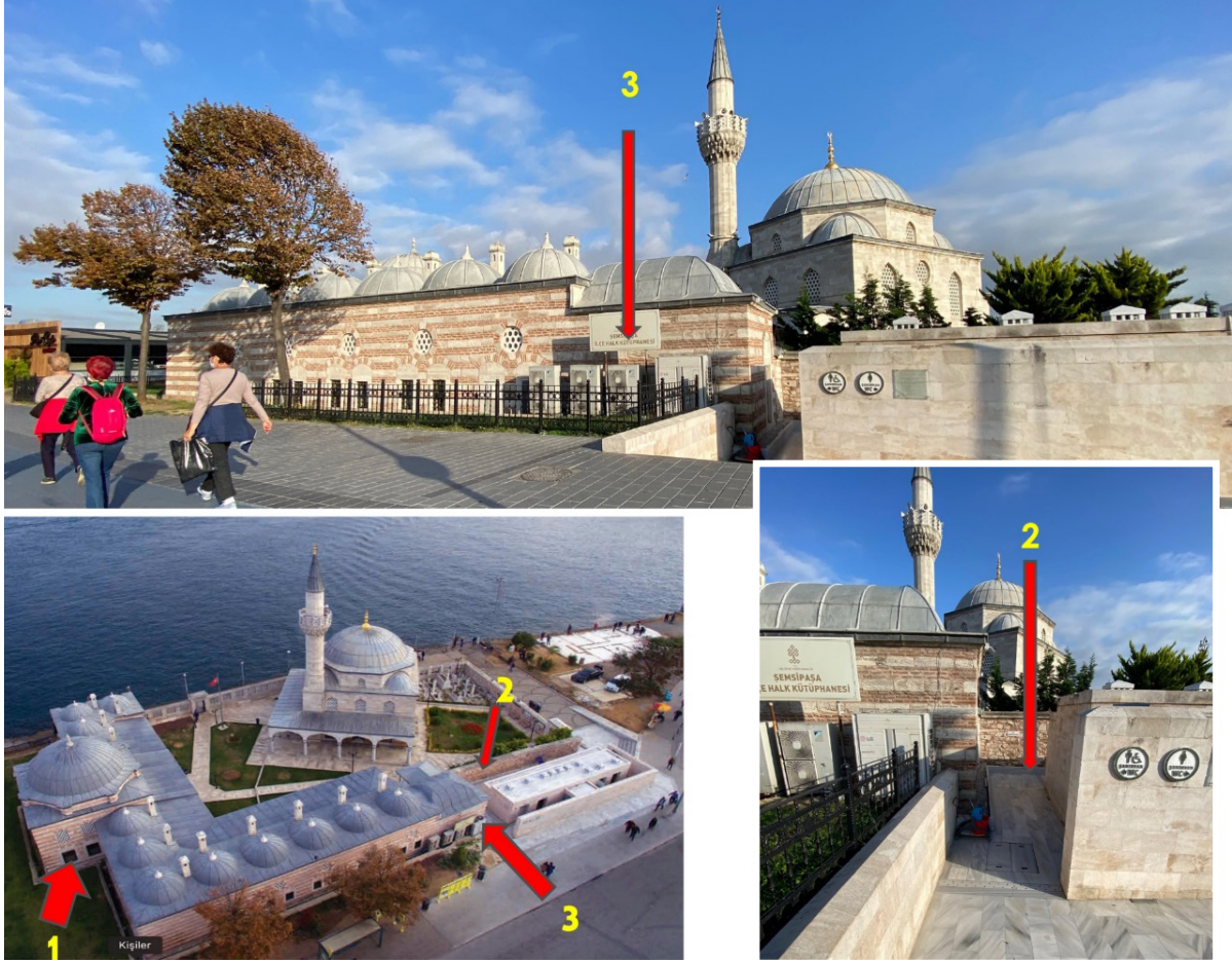
Şekil 7 Üsküdar, Şemsi Paşa Camii'nde teknik altyapı entegrasyonu sorunu
