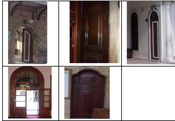
Şekil 4. Giriş kapısı ve avlu'da yer alan kapılarda ahşap malzeme [43]
