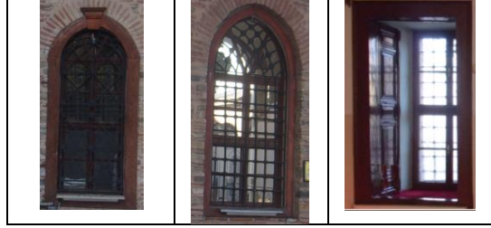
Şekil 5. Pencerelerde ahşap malzeme [43]
