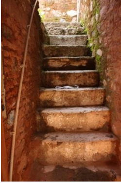
Şekil 8: Fatma Hanım Sebil-Küttâbı Üst Kat Merdiveni
