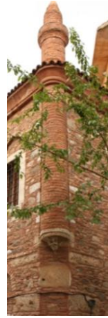
Şekil 5: Fatma Hanım Sebil-Küttâbı Güneybatı Köşe
