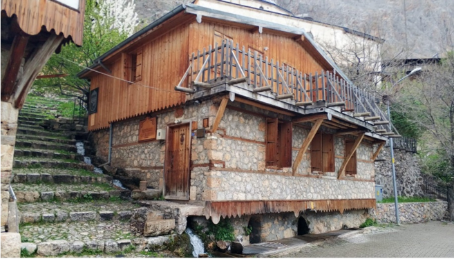
Görsel 3. Değirmen cephe görünüşü.
