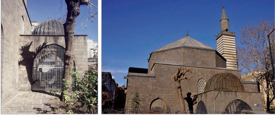
Figür 11 - Zübeyde Hanım Türbesi, Diyarbakır
