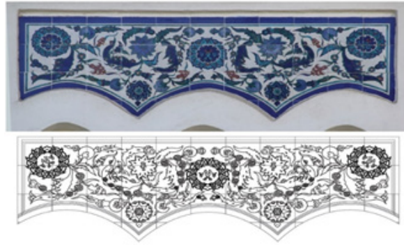
Şekil 3: Devlet Tiyatrosu Binası kuzeydoğu cephesi çini panoları. Ön cephe hasar tespit planı (3a). Binanın genel görünümü (3b). Çini panoların yakından görünümü (3c). Çini panonun desen restitüsyonu (3d). (Serap Işıkhhan Arşivi 2019).
