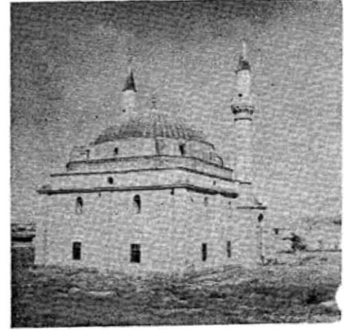
22. Camiin kible tarafından görünüşü.
