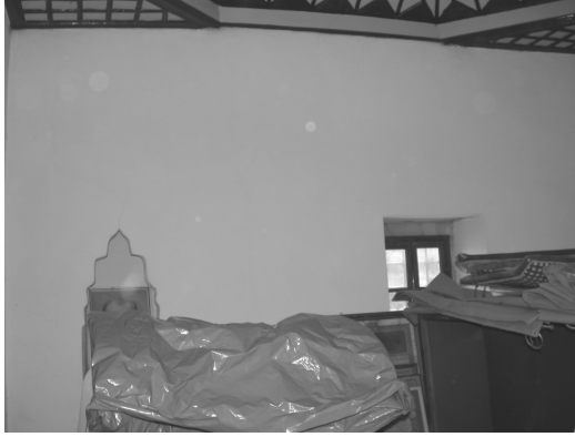
Res.7- Gebze, Çoban Mustafa Paşa Külliyesi Kütüphanesi, doğudaki mekânın kuzey duvarı.
