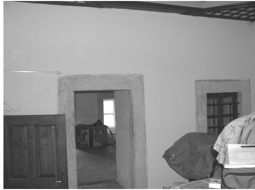
Res.8- Gebze, Çoban Mustafa Paşa Külliyesi Kütüphanesi, doğudaki mekânın batı duvarı.
