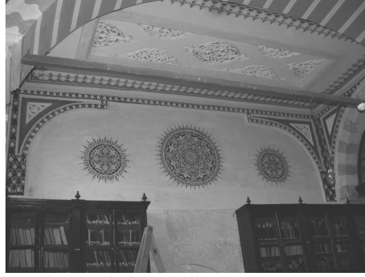
Res.22- Edirne, Selimiye Camii Kütüphanesi, kuzey duvarı.
