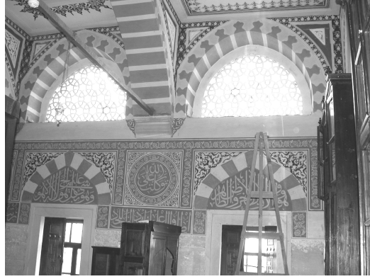
Res. 25- Edirne, Selimiye Camii Kütüphanesi, batı duvarı.
