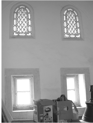
Res.11- Gebze, oban Mustafa Paa Kllyesi Ktphanesi, batıdaki mekânın batı duvarı.
