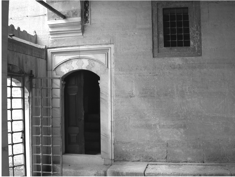
Res.17- Edirne, Selimiye Camii Kütüphanesi, yukarıya çıkış merdivenine açılan giriş.
