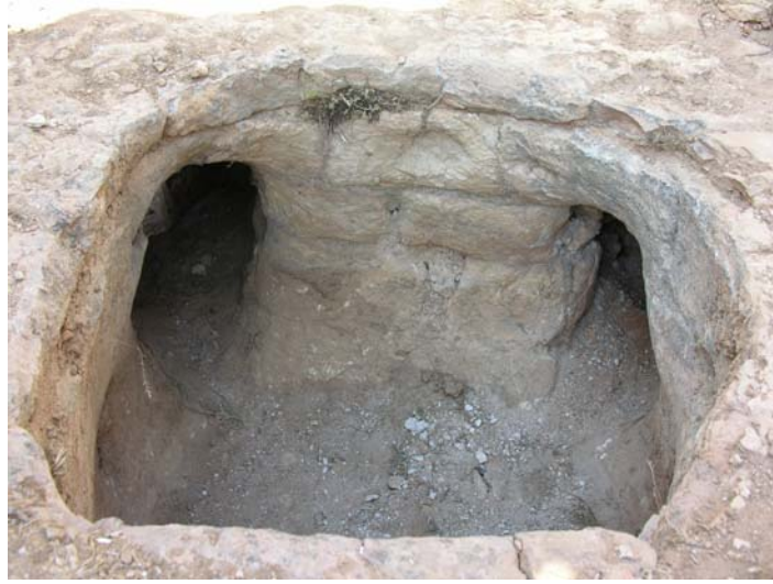
Res. 16- Seymenlik Zaviyesi Hamamı. Su deposundaki kazan yuvası ve cehennemliğe ulaşan duman kanalları.
