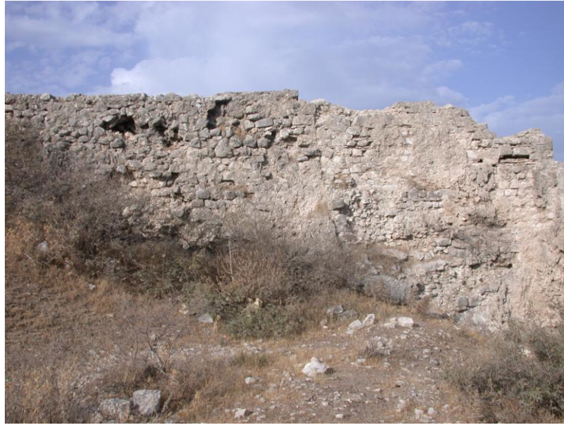
Res.2-Yol üzerindeki su taşıma duvarı.
