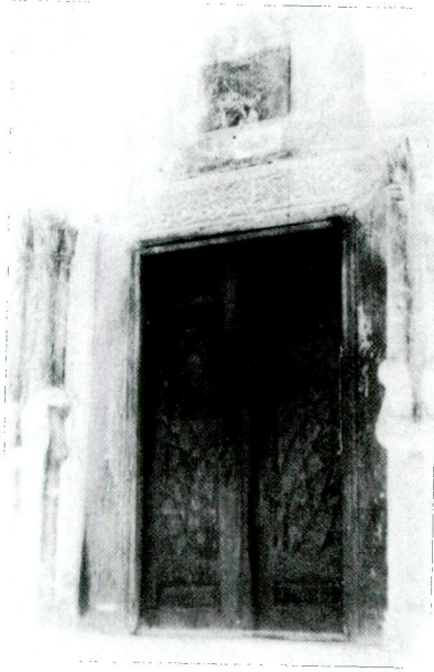
Res. 6 — İshak Çelebi Türbesinin Giriş Cephesindeki Sütunlar
