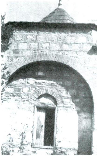
Res. 4 — Revak Sultan Türbesinin Giriş Cephesi
