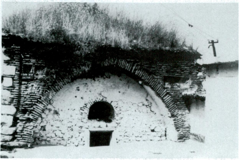
Res. 7 — Yedikızlar Türbesinin Doğu Cephesi
