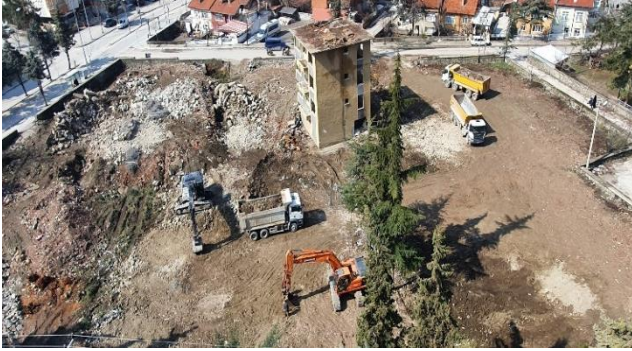
Şekil 10. Yıkıntı atıklarının yıkım alanından uzaklaştırılması
