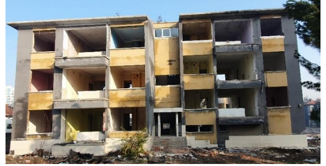
(d) Seçici yıkım işlemi tamamlanmış bina Şekil 7. Binalarda seçici yıkım yapılması
