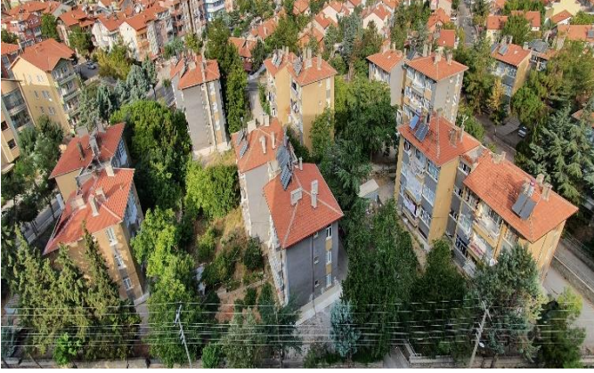
Şekil 6. Yıkımı işlemi gerçekleştirilecek binalar
