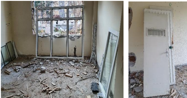
(b) Kapı ve pencerelerin sökülmesi
