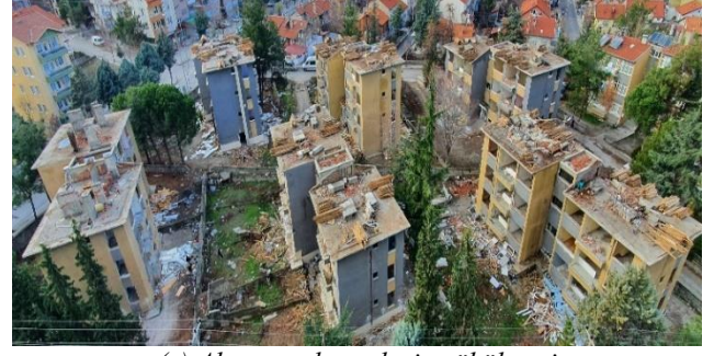
(c) Ahşap malzemelerin sökülmesi
