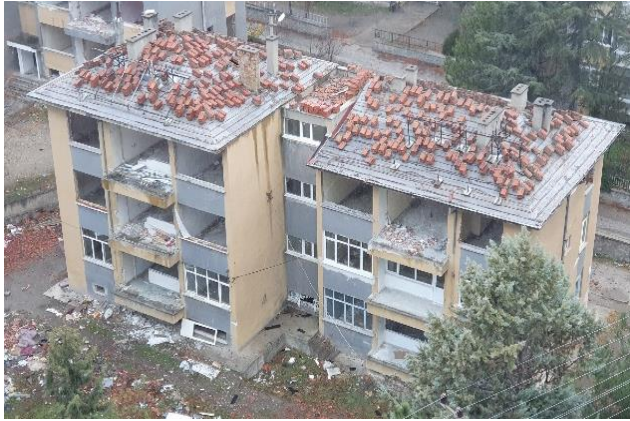
(a) Çatı kaplamasının sökülmesi
