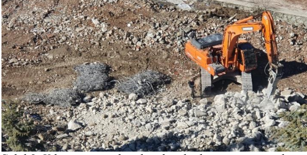
Şekil 9. Yıkım esnasında çıkan hurda demirin ayrıştırılması
