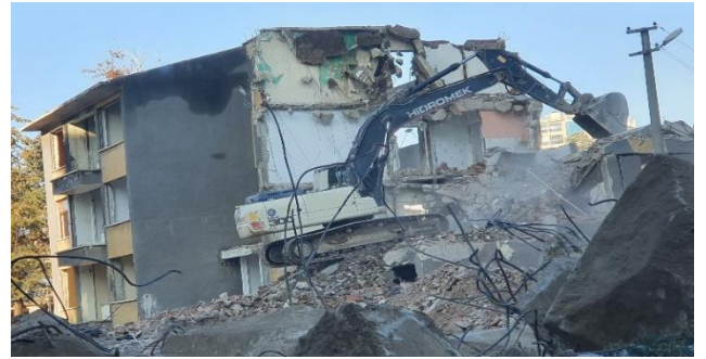
(a) Yıkımı yapılan bina
