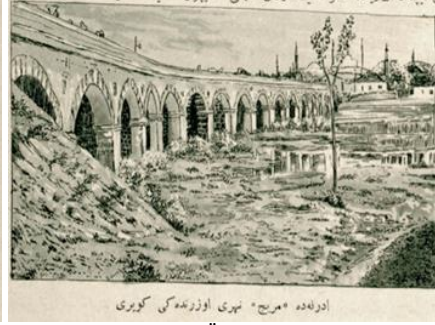
Edirne'de Meriç Nehri Üzerindeki Köprü (Resim 2)
