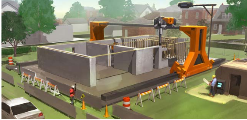
Şekil 1. 3B Beton Baskı Teknolojisi Yardımı ile Konut Üretimi (Khoshnevis, 2015)
