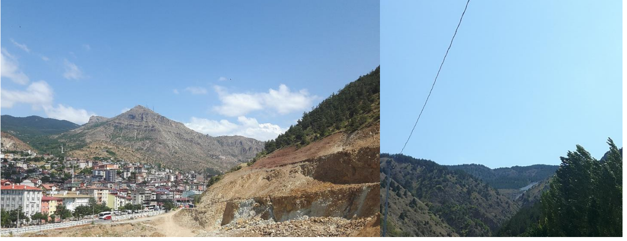
Şekil 4. Kuşakkaya ve Gümüştaş kurşun/çinko/bakır-altın/gümüş maden sahası
