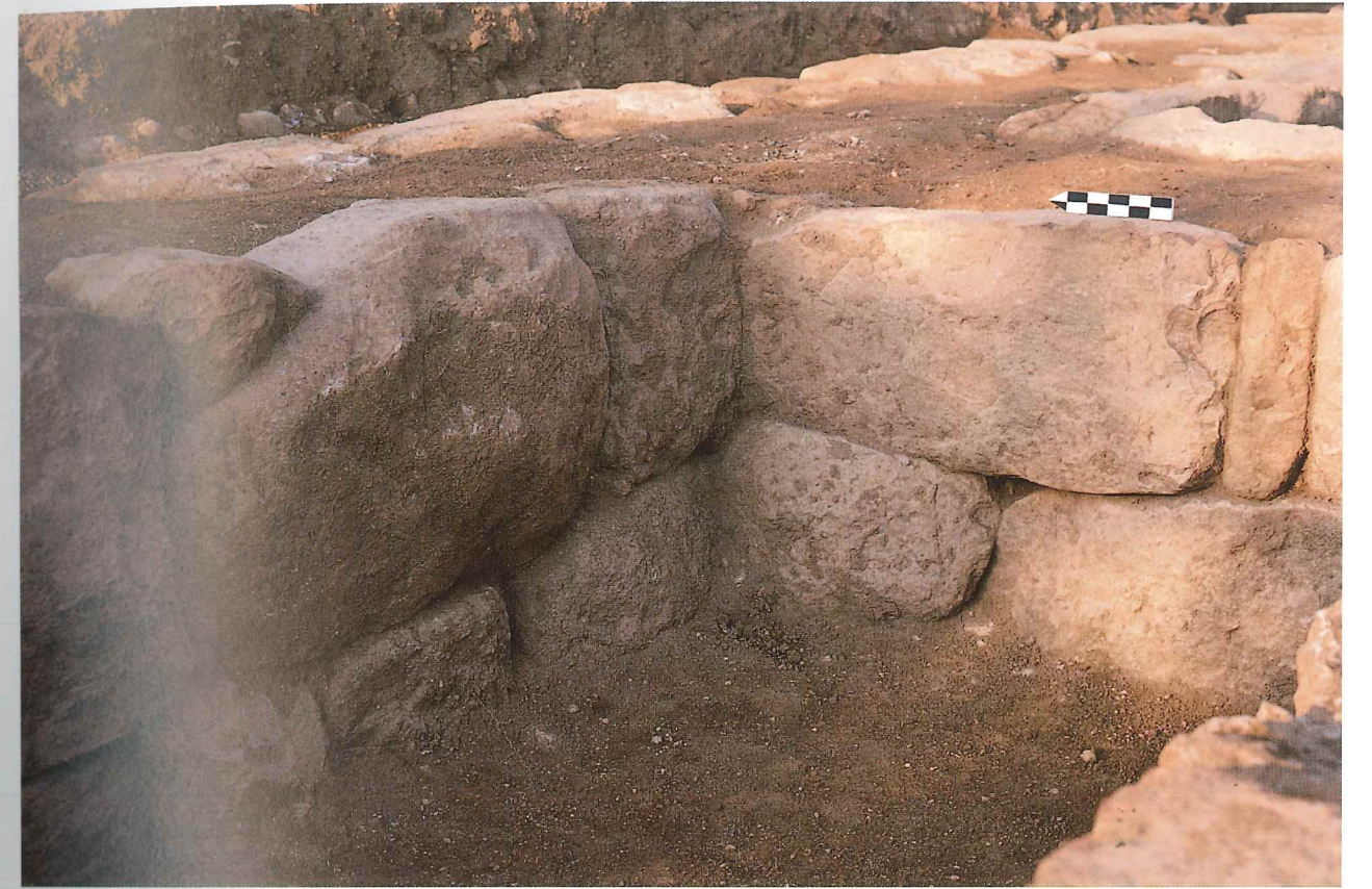
Resim 3: 'A' binası temel duvarlarından bir detay.
