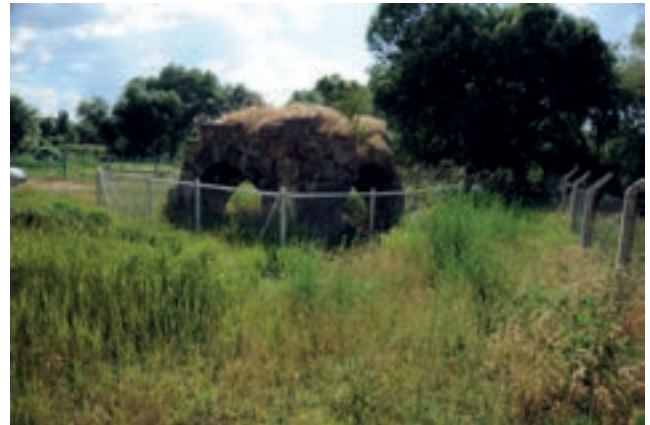
Fig. 14 - Dört Kemerli Köşk Genel Görünüm (O. Eravşar)
