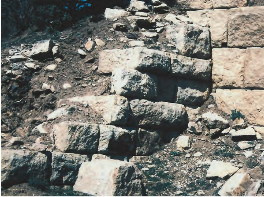
Figure 8: Fourth Phase Wall of the Military Signal Station / Askeri Gözlem Karakolu'nun Dördüncü Evre Duvarı
