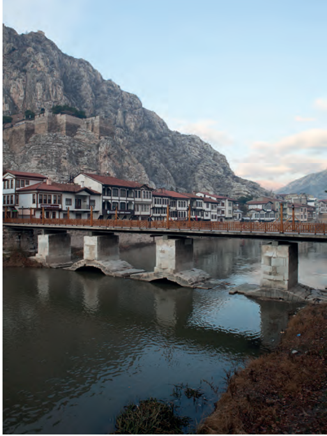
Resim 24: Alçak Köprü, Genel Görünüş / The Alçak Bridge, General View
