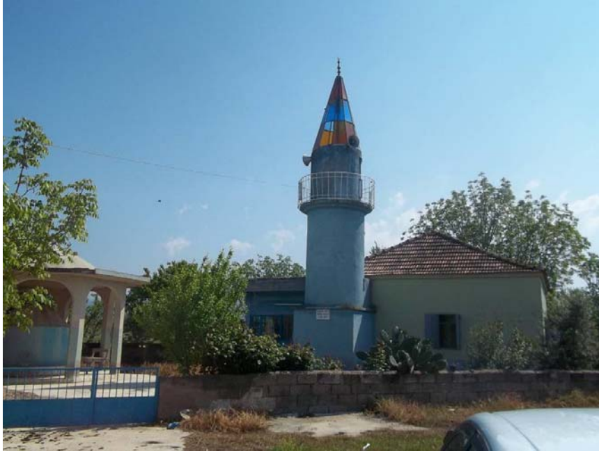
Fotoğraf.8-Ödemiş Bayındır Yakacık Köyü Şirinkır Cami-Batı Cephe
