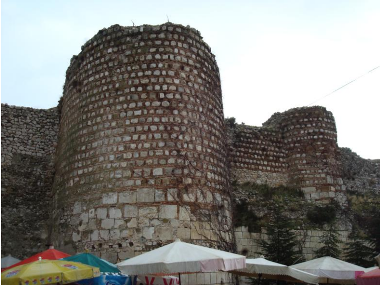
Foto.4- Eğirdir Kalesi. Silindirik Burç.
