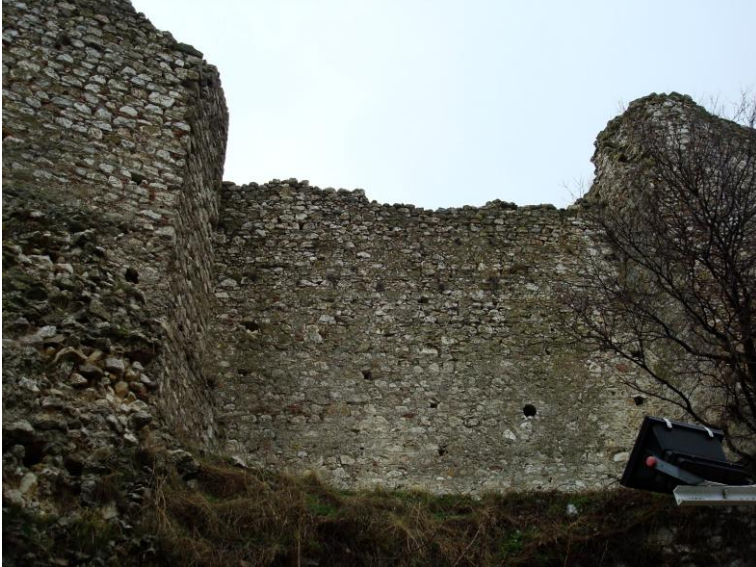
Foto. 20- Eğirdir Kalesi. Kalenin üst kesimindeki sur duvarı.
