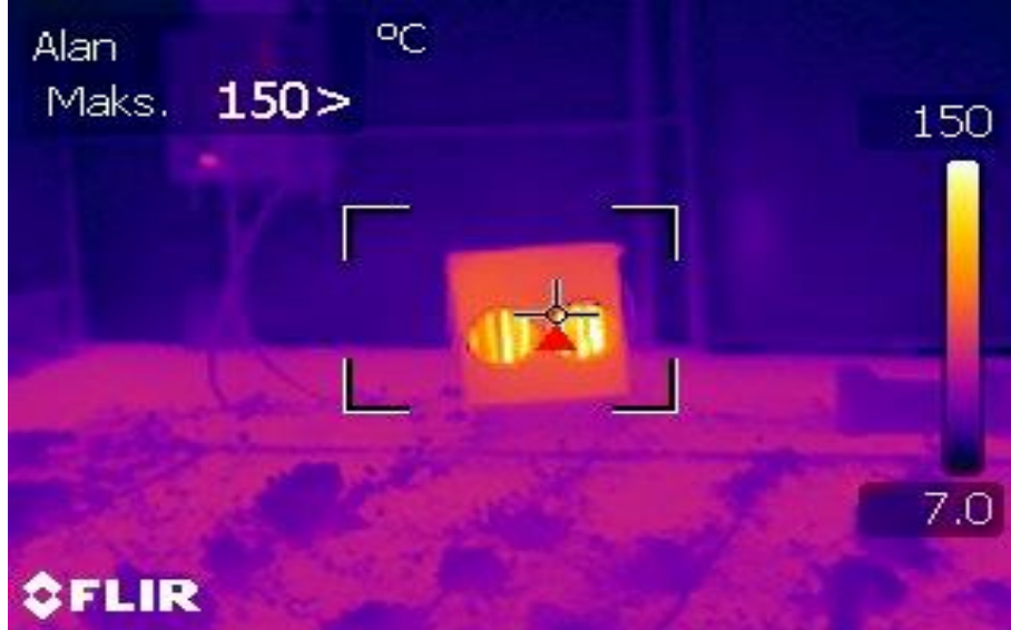
Şekil 10. Sıcak hava üfleme ısıtıcı termal görüntüsü
