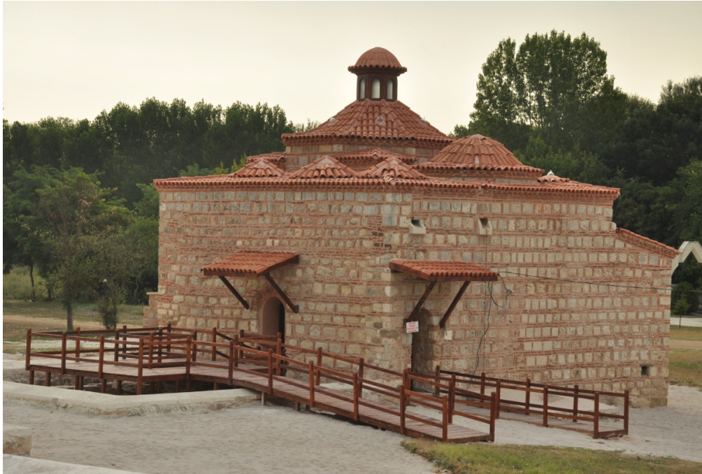
EYSK, Edirne Yeni Saray, Kum Kasrı Hamamı'nın restorasyon sırasındaki görünümü
