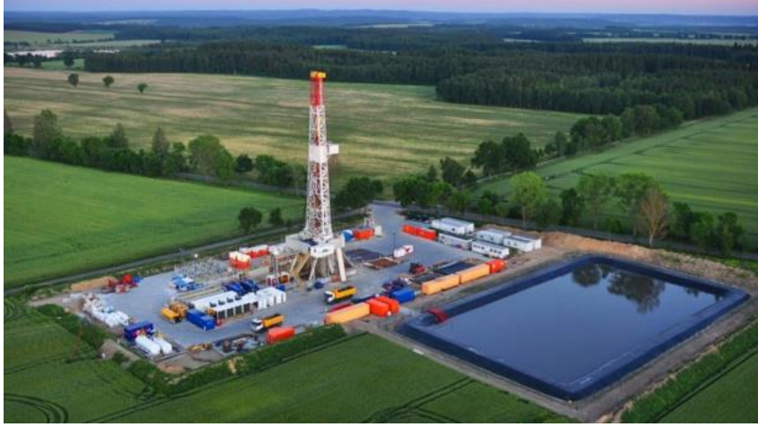
Şekil 5. Şeyl gaz üretimi yapılan bir sahada geri alınan suyun biriktirildiği açık bir havuz (globalresearch.ca)
