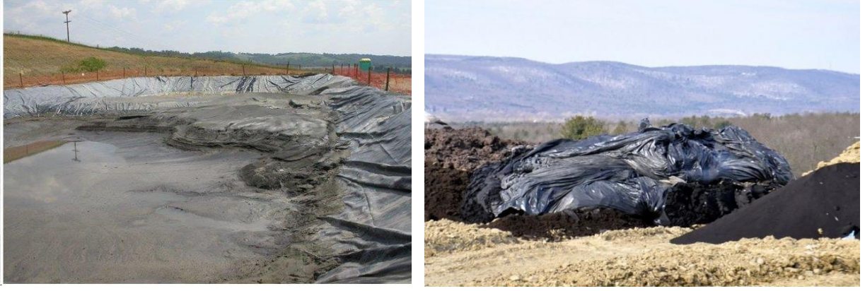
Şekil 3. Geri alınan çatlatma sıvılarının biriktirildiği havuzlar ve bu atıkların çöp depo alanına nakliyesi için paketlenmesi (www.frackcheckwv.net).
