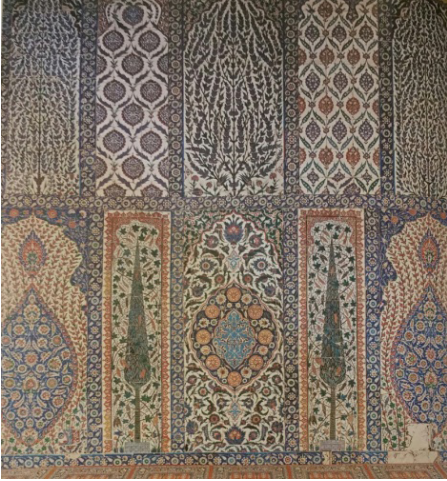
Resim 14. Çini döşeli duvar, Sultanahmed Camisi (Kuban, 2006: 446).
