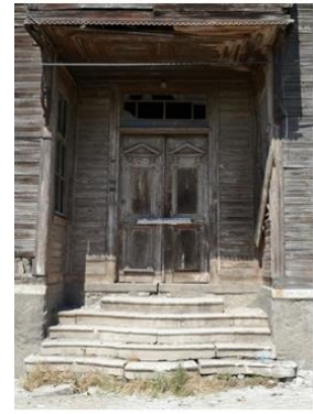
Şekil 23. Merdiven Önden (3 No'lu Konut)
