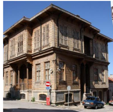
Şekil 33. Bodrum kat hizasında taş; katlar arası pro- filli ve ahşap köşe dikmeleri (12 No'lu Konut)
