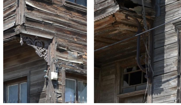
Şekil 35. Metal Eliböğünde Örnekleri (Solda 28 No'lu Konut, Sağda 3 No'lu Konut)
