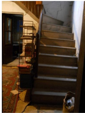
Şekil 9. L Formda Merdiven (15 No'lu Konut)
