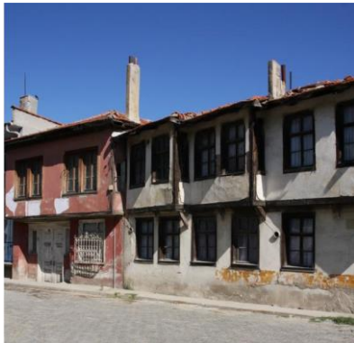
Şekil 32. Duvar boyunca devam eden düz ahşap ya- tay silmeler ve ahşap köşe dikmeleri (Solda 25 No'lu Konut, Sağda 13 No'lu Konut)
