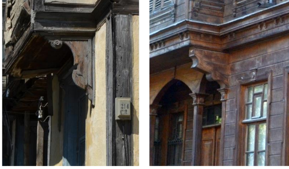
Şekil 34. Ahşap Eliböğünde Örnekleri (Solda 22 No'lu Konut, Sağda 12 No'lu Konut)
