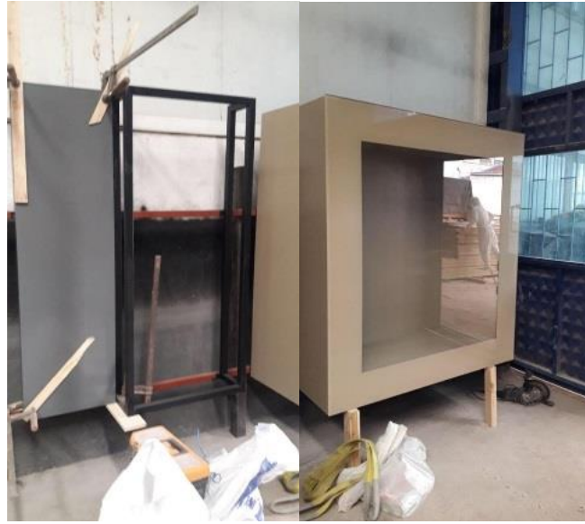
Şekil 25. Oda 3’de yer alan çini taşlarının sergileme donatısı ve anlatı panosu uygulama süreci
