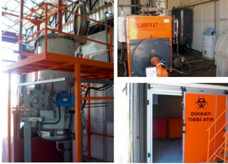
Şekil 2.2. Elazığ İli Sterilizasyon Tesisi [18, 20]
