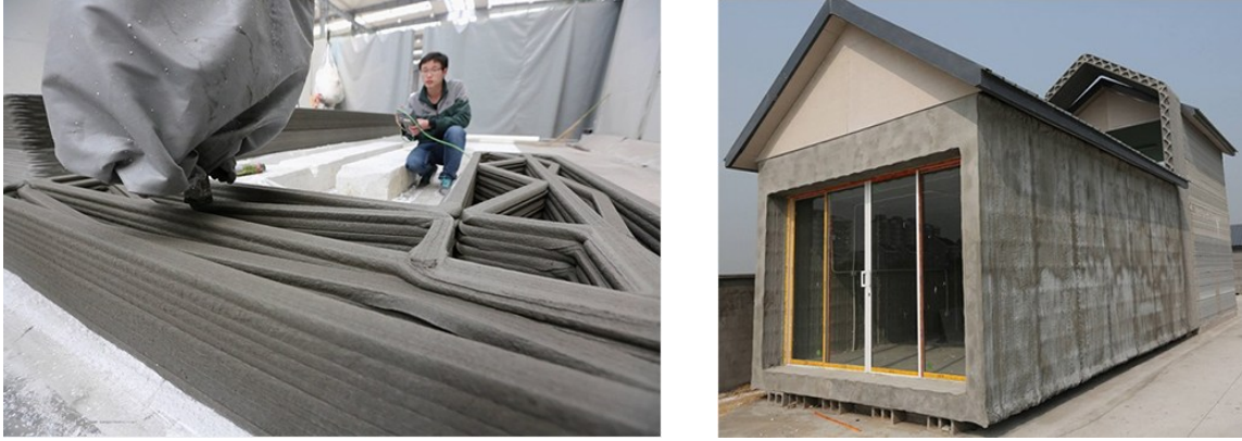
Şekil 2. 3B beton yazıcı ile katman katman dökümle üretilen yapılar [9].
