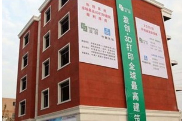
Şekil 4. 3B yazıcı ile yapılmış 5 katlı bir bina [24]
