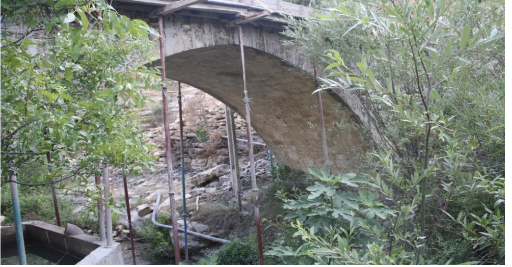
Fotoğraf-2. Eşekçi Köprüsü ayrıntı.
