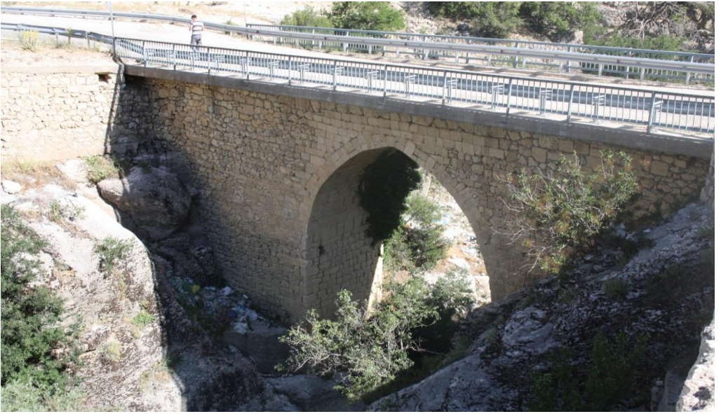
Fotoğraf-2. Arı Köprüsü kuzey cephe.
