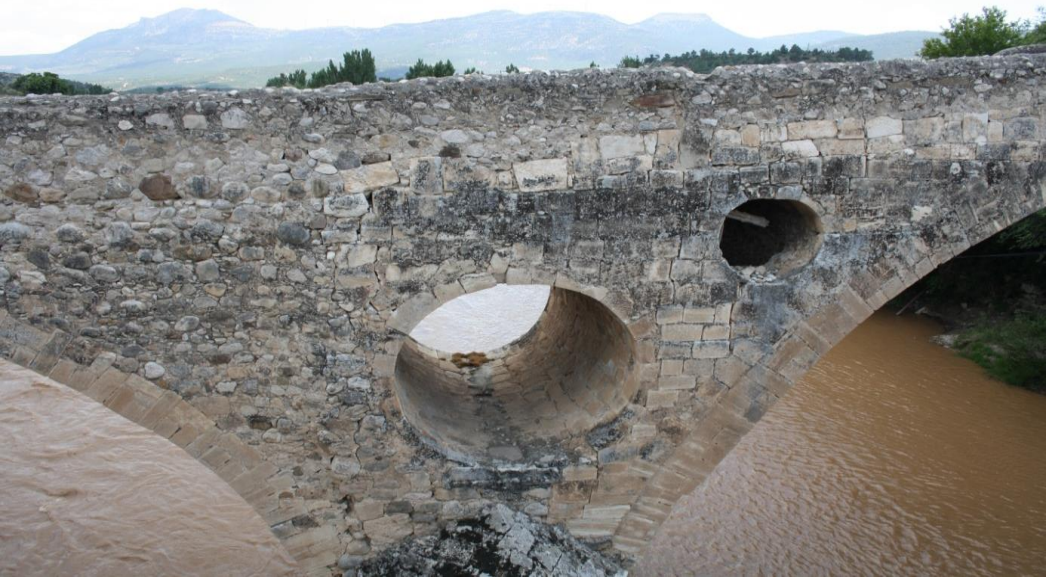
Fotoğraf-10. Kravga Köprüsü boşaltma gözleri.
