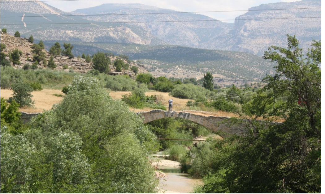
Fotoğraf-14. Yapıntı Köprüsü genel görünüm.
