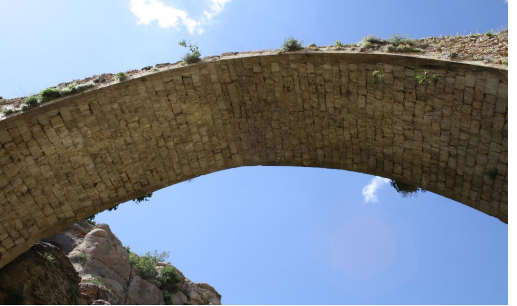
Fotoğraf-8. Keven Köprüsü sivri kemer ayrıntı.
