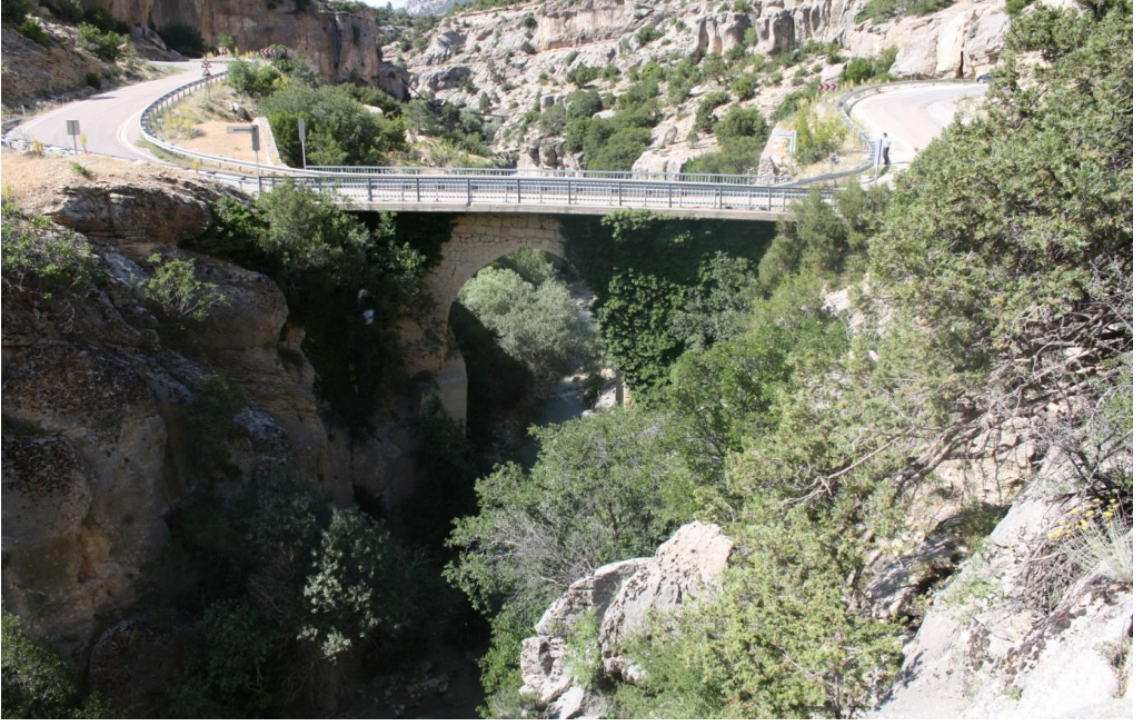
Fotoğraf-1. Arı Köprüsü genel görünüm.
