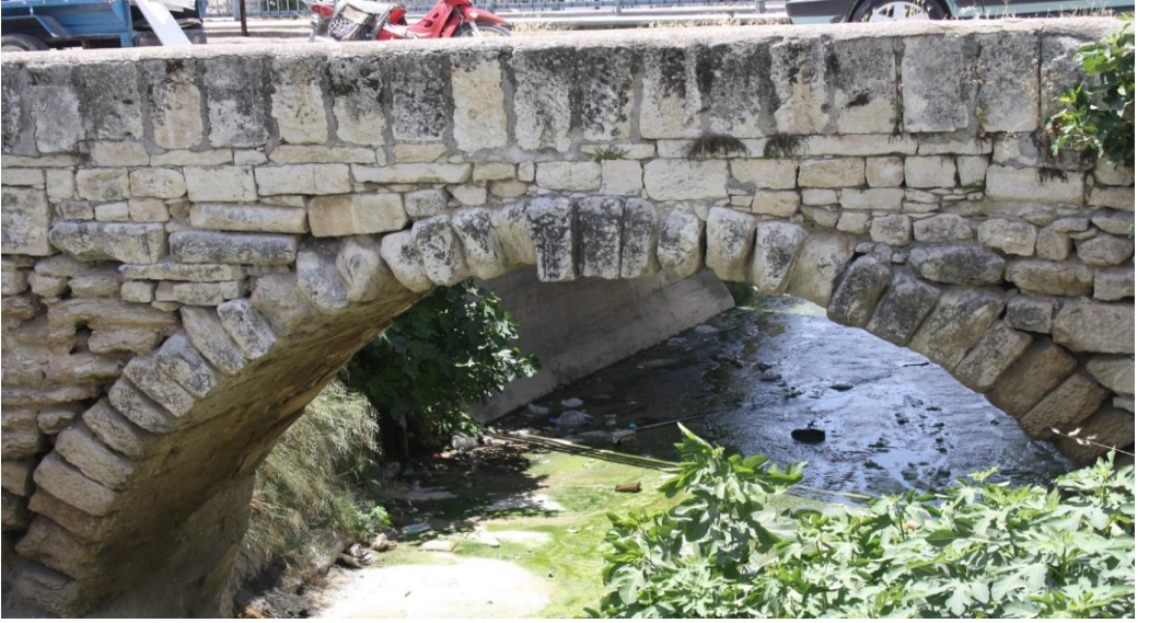
Fotoğraf-13. Taş Köprü kemer detayı.
