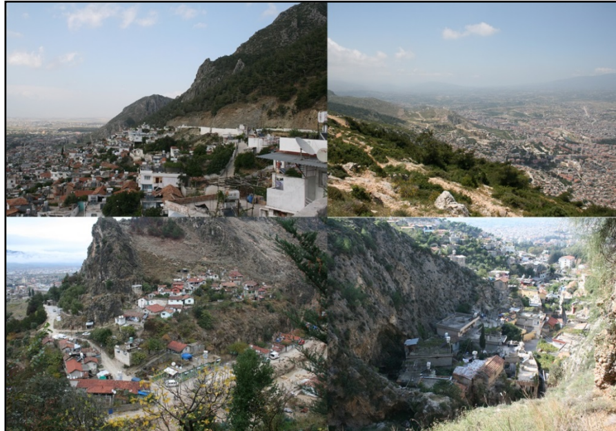
Şekil 6. Çalışma alanında kütle hareketleri riski olan yerlerin görünümü Şekil 6. View of the areas with risk of mass movements in the study area
