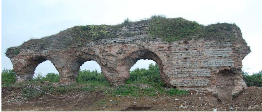
Resim 27 Roma Hamamı yanında yer alan su kemeri (aqueduct)
