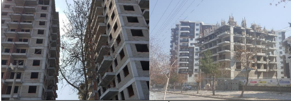
Resim 4: Kentsel Dönüşüm Kapsamında Yapılan İnşaatlar
