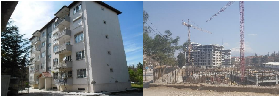
Kentsel Dönüşüm Risk Firması Tarafından İncelenmiş Bir Bina
