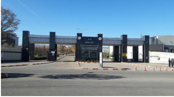
2.3. B.Ü. Ana nizamiye giriş kapısı
