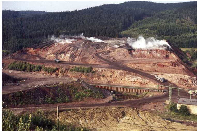
Şekil 12. Katerina kömür-atık yığını yangını (Foto Energie–Stavební a báňská Corporation, Kaynak: Klica ve Martinec, 2013)
