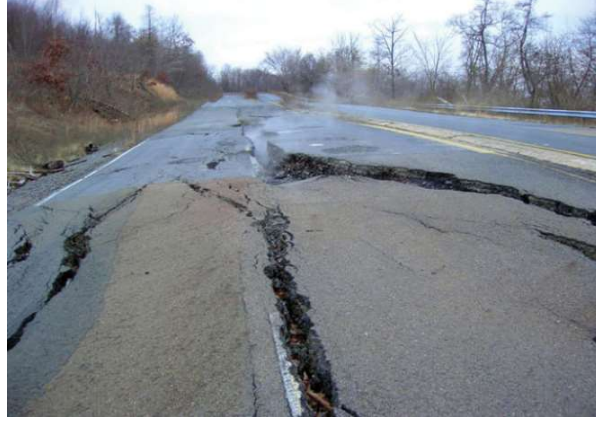
Şekil 1. Pennsylvania'da yeraltındaki kömür yangını sonucu çöken yol (URL - 1, 2008)
