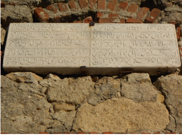
Resim 17. Eceabat-Kilitbahir Köyü Tâlib-i İrşâdî Tekkesi 2. kapı üzerindeki onarım kitabesi
