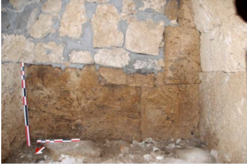
Resim 5: Duvar Örgü Tekniğini Gösterir Fotoğraf
