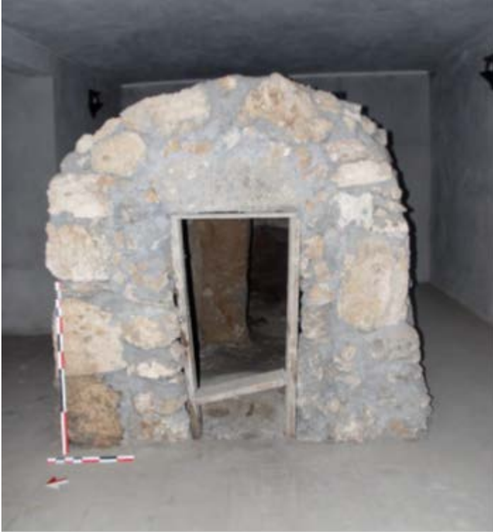
Resim 4: Çimento Harcı Kullanılarak Onarılan Bölümlerden Örnek
