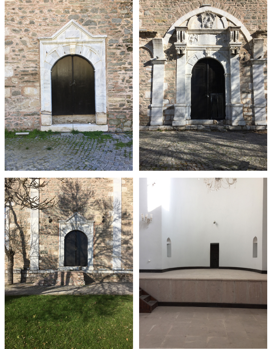
Görsel 12. Yapı içinde ve dışında engelli kullanıcılara basamak engeli
