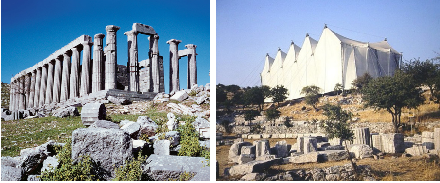
Görsel 9. Apollo Epicurius Tapınağı koruma örtüsü, Girit Adası, Yunanistan (solda),
