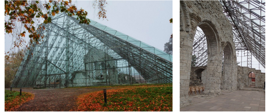
Görsel 5. Hamar Katedrali kalıcı koruma örtüsü, Norveç (solda),
