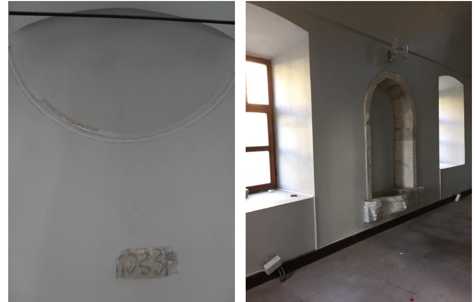
Görsel 15. Restorasyon sonrası yapıda bulunan eskiye ait izler
