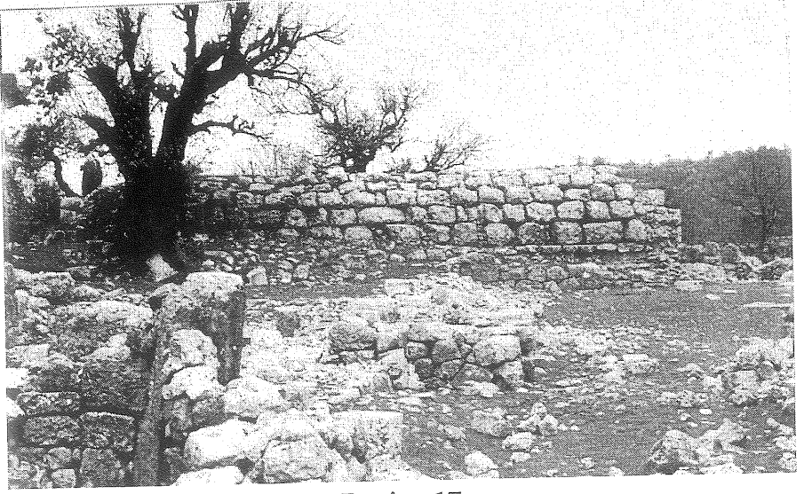
Resim 17 Üç Ayaklı, su deposunun batı dış duvarı
