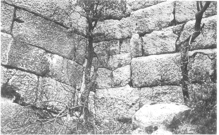
Resim 20 Yeni Yurt, 2. kulenin yanındaki çokgen taş duvar ilavesi
