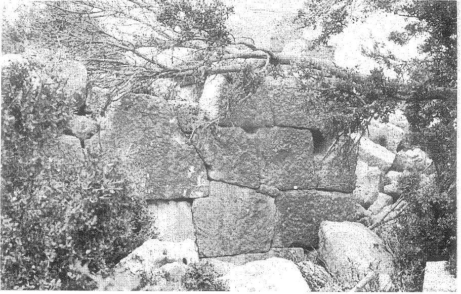
Resim 19 Hisar Kalesi, çokgen taştan yapılmış evin duvarından detay
