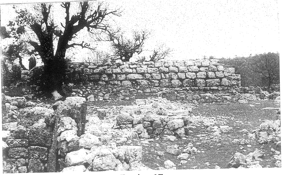
Resim 17 Üç Ayaklı, su deposunun batı dış duvarı
