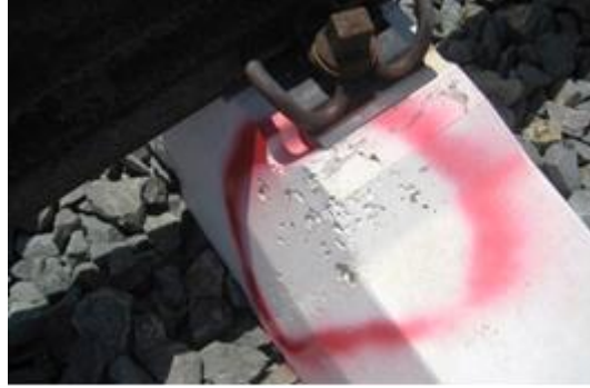
Şekil 4. Yetersiz vibrasyondan kaynaklı oluşan hava kabarcıkları [21]
