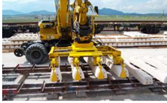
Şekil 6. Panel montajının yapılışı [21]
