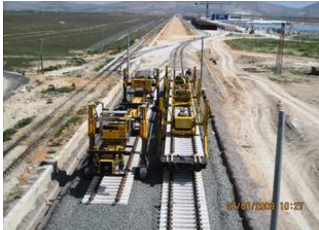
Şekil 8. Panel sistemi ile hat döşenmesi [21].
