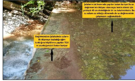
Fotoğraf 8. Değirmendere şelalesinin en üstünde su değirmenine su temin etmek için yapılmış beton bariyer ve gerisinde biriken su..
