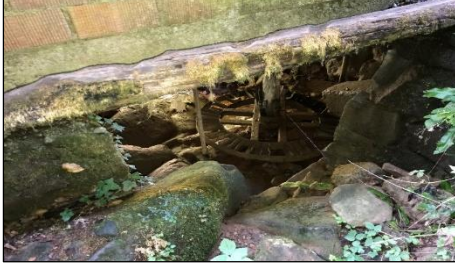
Fotoğraf 11. Su değirmeninin çalışmasını sağlayan alt kısımdaki çark.
