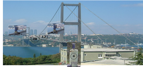
Şekil 4: 6 numaralı referans noktasından 20 ve 22 numaralı obje noktalarının GPS ile ölçülmesi
