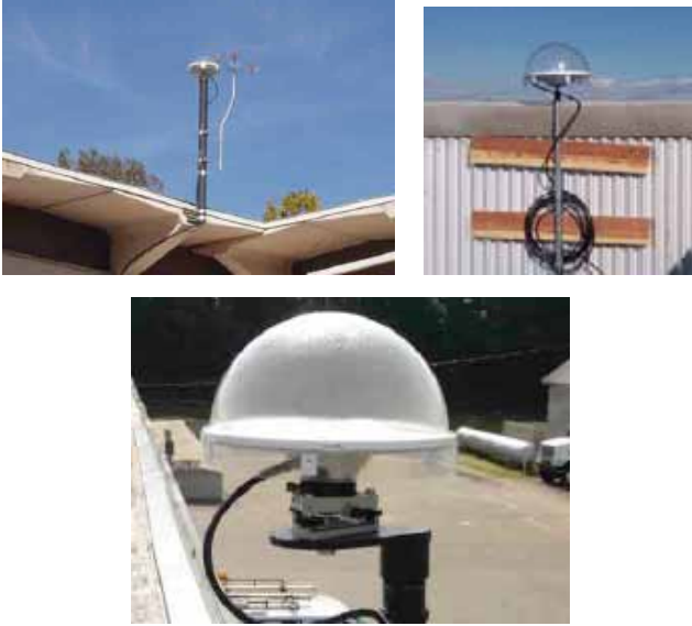
Şekil-1. Yanlış anten kurulum örnekleri
