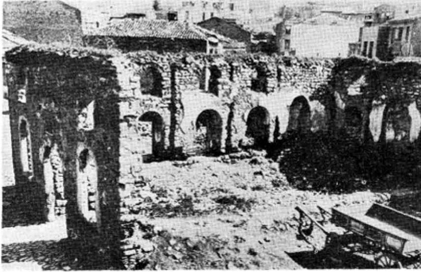
Resim 22. Hacı Teberrük camii 1941 de.
