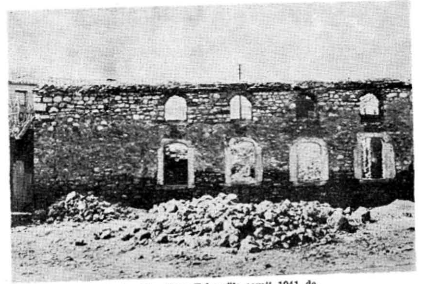
Resim 20. Hacı Teberrük camii 1941 de.
