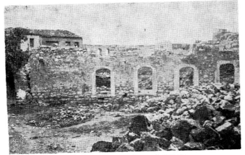
Resim 21. Hacı Teberrük camii 1943 de.
