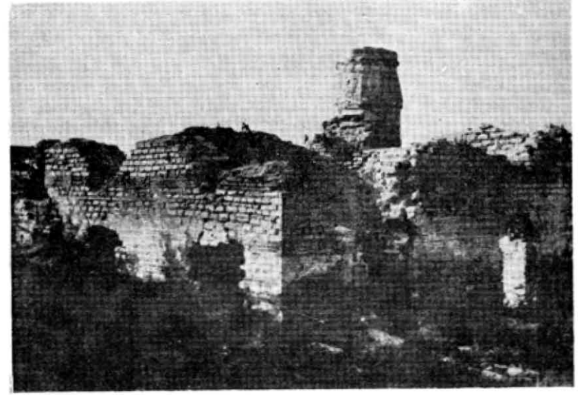
Res. 37. Kasım mescidi kible duvarı yıkılmadan.
