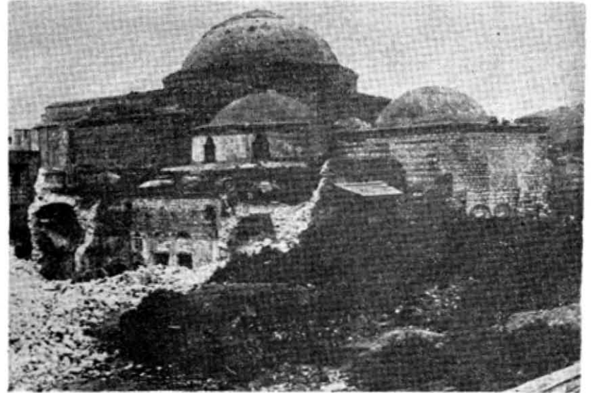
Res. 23. Çukurçeşme hamamı (ön plânda pencereli küçük kubbeli ve harap yapı Lâleli medresesidir).
