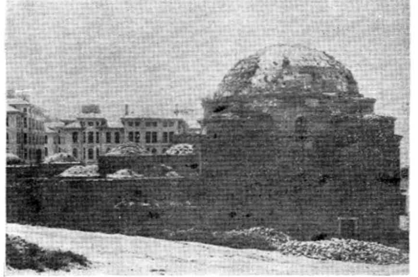
Res. 22. Çukurçeşme hamamı yan cephesi ve erkekler kısmı (Arkada solda eş kubbeli yapı Lâleli medresesi, daha arkadaki büyük bina Hava Kurumu Apartmanıdır).
