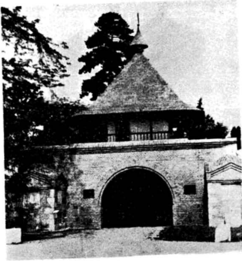
Res. 2 : Goleşti konağının avlu kapısı ve çeşme.
