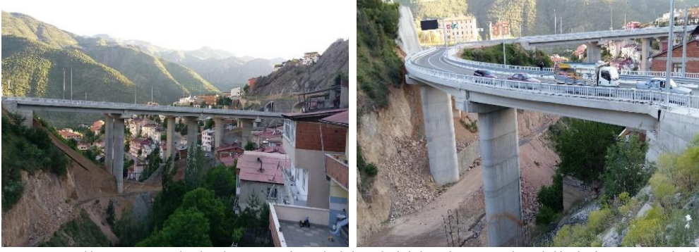
Şekil 19. Tüneller arasında bulunan viyadüklerdeki bariyer yüksekliğinin yetersizliği [1].
