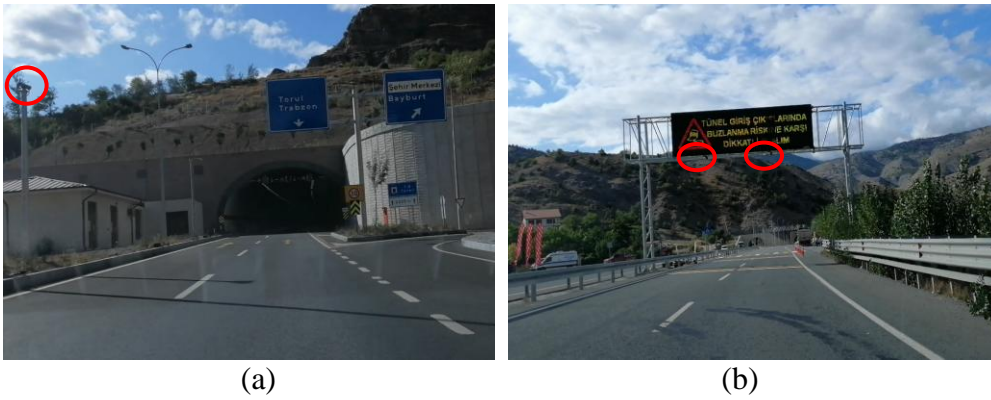
Şekil 6. Tünellerde bulunan plaka tespit sistemleri.
