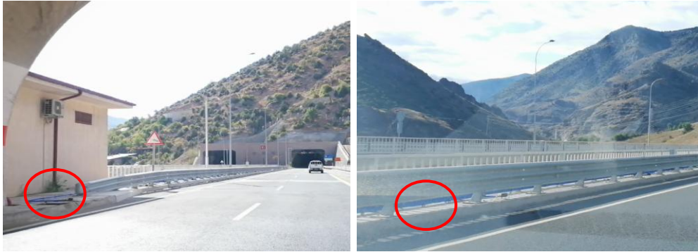
Şekil 8. Tünel giriş ve çıkışlarında yer alan otomatik buzlanma önleme sistemlerine ait görseller.
