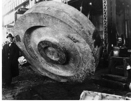
Şekil 2. USS Henderson'daki cayro yalpa önleyici rotoru [2].
